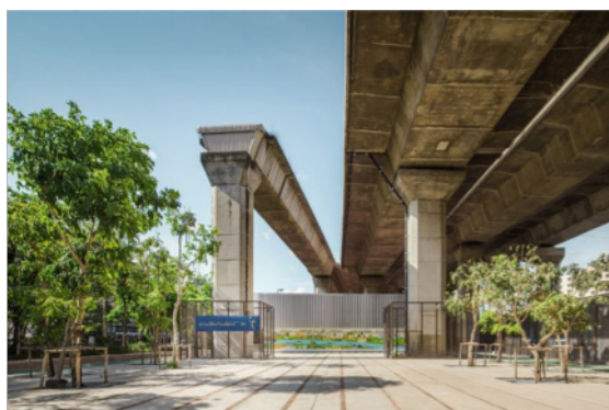
GAMBAR 8. Keadaan selepas projek pembangunan ruang awam terbuka di bawah jambatan Lan Kila Pat 2 Sumber: Shma SoEn
