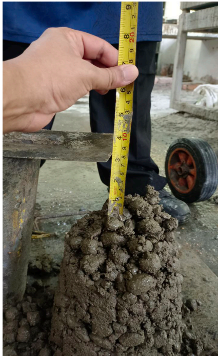
RAJAH 8. Ujian Turun dijalankan
