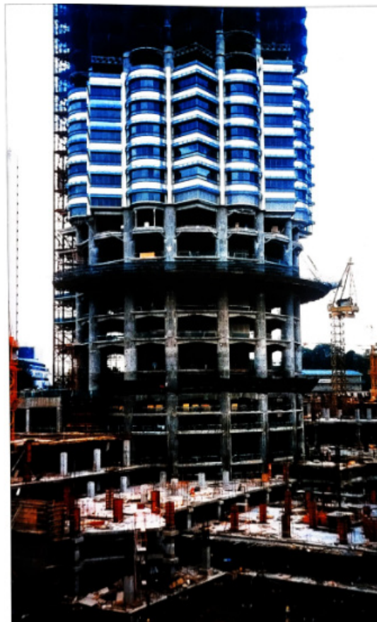
RAJAH 7. Tiang konkrit yang merupakan struktur utama Menara Berkembar PETRONAS Sumber: Cesar Pelli (2005)
