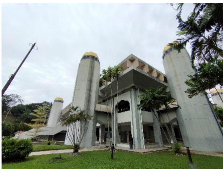
RAJAH 18. Pelan lantai tingkat paling atas yang besar memberi teduhan kepada dinding dan bukaan tingkat bawah.
