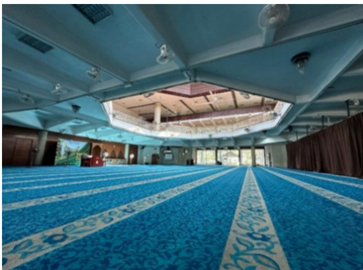
RAJAH 17. Mempunyai bukaan pada lantai tingkat satu yang membantu pengudaraan dan cahaya semula jadi.
