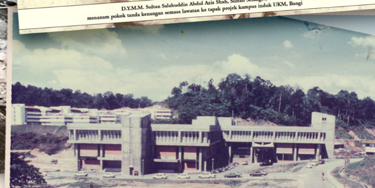
Proses Pembinaan Bangunan di UKM
